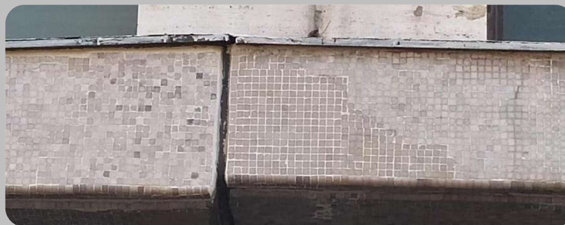
Particolare dopo il restauro
