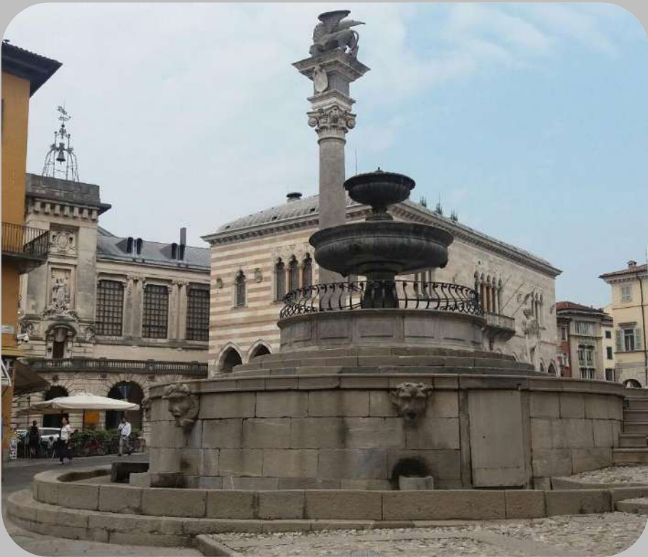
Fontana di Giovanni Carrara prima del restauro
