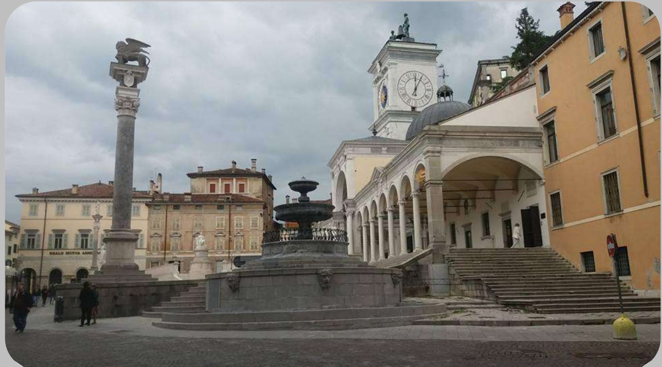
dopo il restauro
